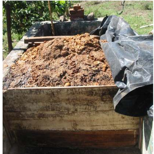
Pileta de concreto subdividida
