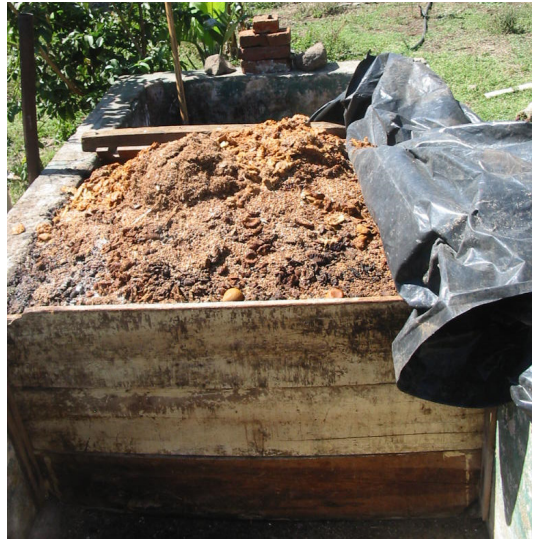
Pileta de concreto subdividida
